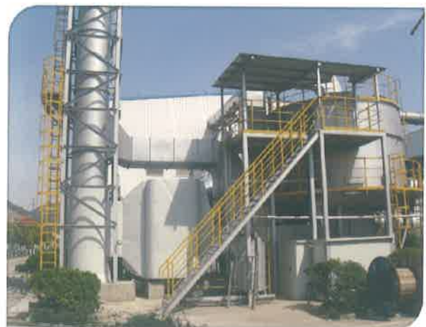
旋转式 RTO 项目名称：宁波综研化学 应用行业：胶带涂布
