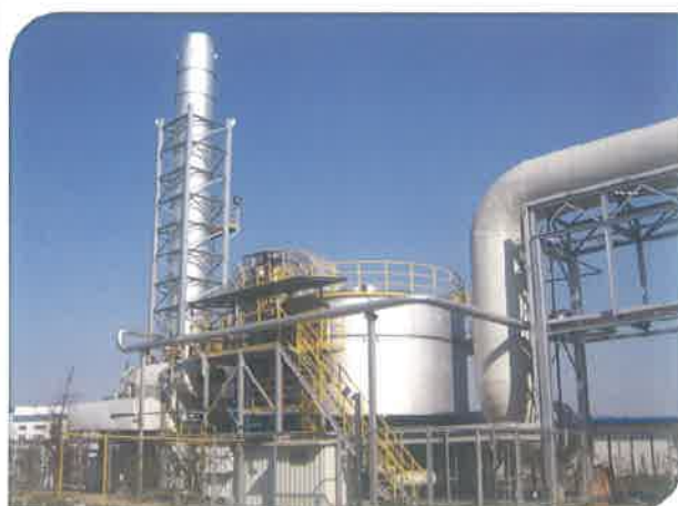
旋转式 RTO 项目名称：上海申永烫金 应用行业：烫金印刷
